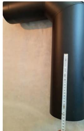
**3.** Am Ofenrohr wird ein Bereich von 250 mm Länge angezeichnet, abgeschnitten und entgratet.
