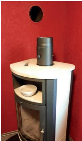
**2.** Der KaminFILTERKat sitzt oberhalb des Ofens und ersetzt den unteren Teil des Ofenrohrs. Der Katalysator sitzt im Rohr in Pfeilrichtung vom Ofen weg.
